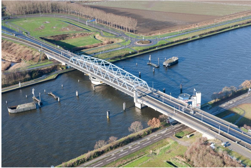
Foto 2. De gecombineerde weg/spoorbrug bij Sluiskil
